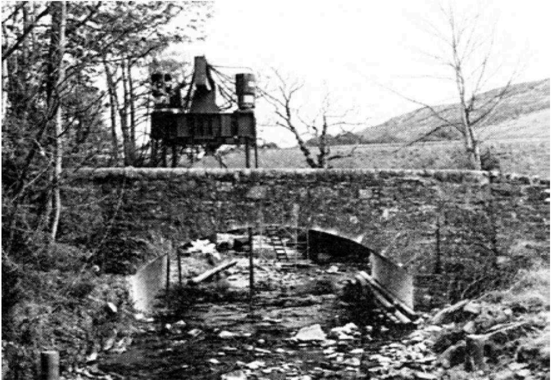
Figure 76 : Le Shinafoot Bridge avant l'essai.
