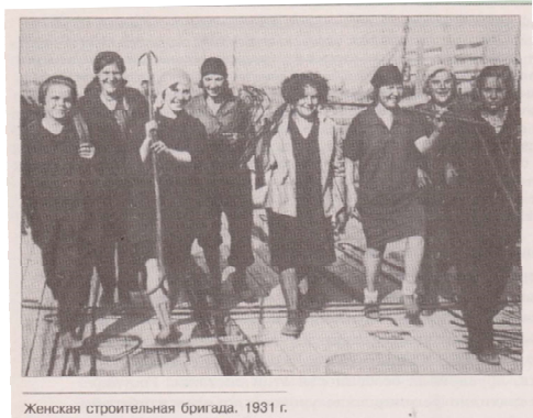
Женская строительная бригада. 1931 г.
