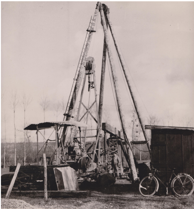
Figure 16 . Essai de forage profond sans les prés des marais à Saint maixent. Vers 1950. AD79 135 J 16
