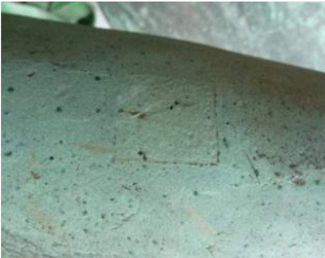
Figure IV 2.2-29 : Apollon du Belvédère. Plaquette de réparation présente sur le bras droit (20 x 20 mm). © C2RMF M Castelle
