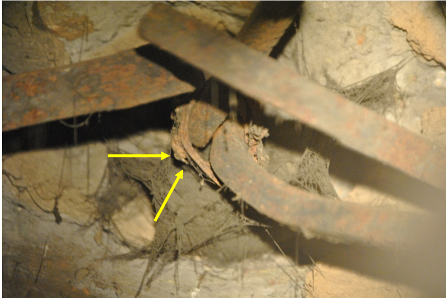
Figure IV 1.3-13 : Justice. Vue de l'intérieur de la Justice juste en dessous de la base du cou. On voit nettement un des deux fils de fer (flèches jaunes) qui maintient les deux armatures principales (section carrée chanfreinée 10 mm) solidaires entre elles alors que les armatures plates (large de 10 mm) qui se dirigent dans les bras sont « flottantes ». Remarquer les restes de noyau argileux de couleur ocre. © C2RMF, M Castelle
