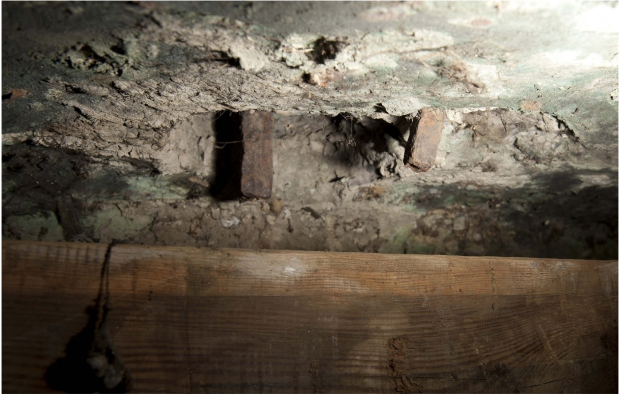
Figure IV 1.1-14 : Laocoon. Armatures se dirigeant dans le drapé de l'enfant à la gauche du Laocoon, section rectangulaire 20x30mm (à gauche) et vers le pied droit de l'enfant à la gauche du Laocoon, section carrée 20x20mm (à droite) © C2RMF A.Maigret
