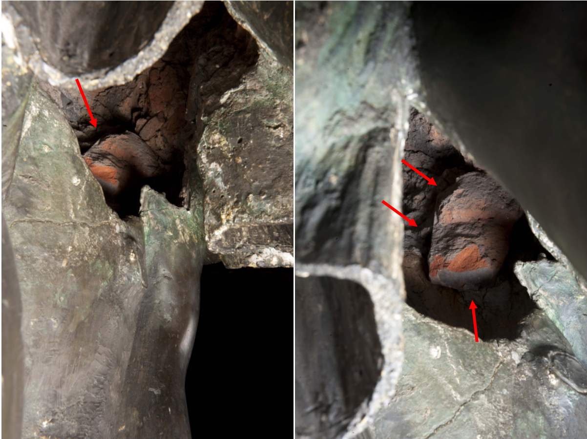
Figure IV 2.1-6 : Diane chasseresse. Vue de l'ouverture sous la statue au niveau de l'entrejambe qui permet l'observation directe de l'intérieur et en particulier au niveau de l'abdomen : du noyau est encore présent. Il est constitué d'une matrice argileuse et de briques (flèches rouges) © C2RMF A Maigret
