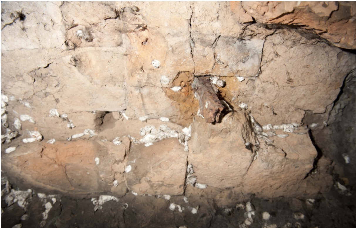
Figure IV 1.1-12 : Laocoon. Vue de l'intérieur de la statue, structure du noyau composé de briques (10 à 15 mm de côté) et d'un mortier argilo-sableux. Armature se dirigeant dans le buste du Laocoon, section rectangulaire 20x30mm © C2RMF A.Maigret
