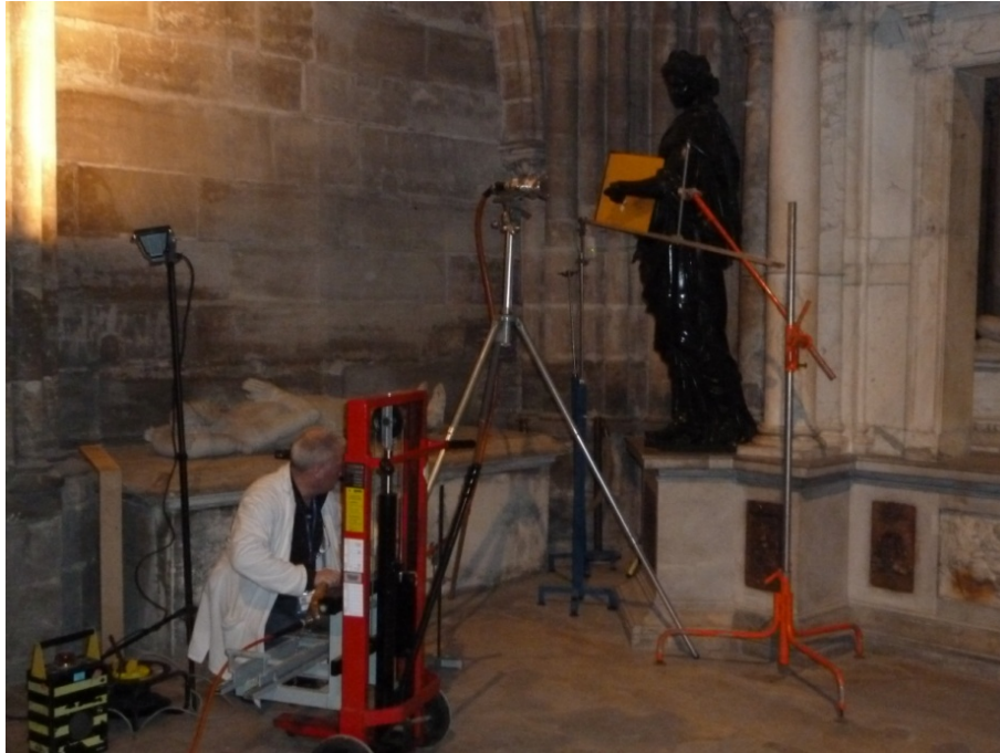
Figure III 2.3-19 : Vue générale du chantier montrant le tir réalisé sur le bras gauche de la Prudence monument Funéraire d'Henri II et de Catherine de Médicis à la Basilique Saint Denis
