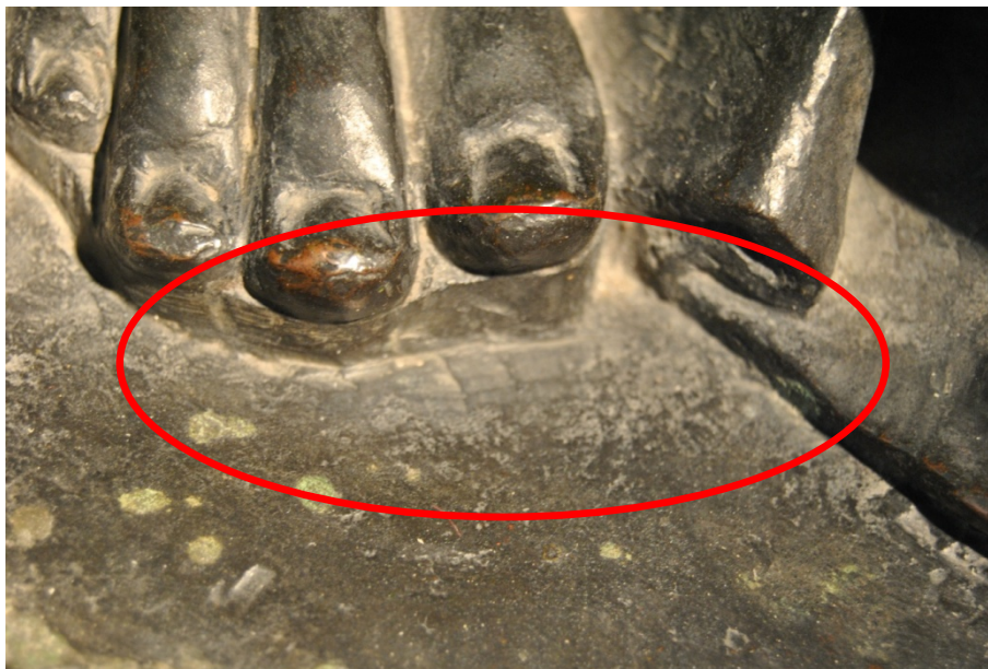
Figure IV 1.3-43 : Justice . Détail du socle au niveau du pied droit. On perçoit les traces de ce qui semble être un martelage à froid © C2RMF M Castelle
