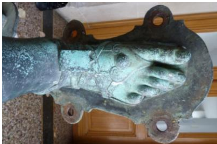
Figure IV 2.2-22 : Apollon du Bélvédère . Vue du dessus du pied droit équipé de son patin de soclage © C2RMF M Castelle
