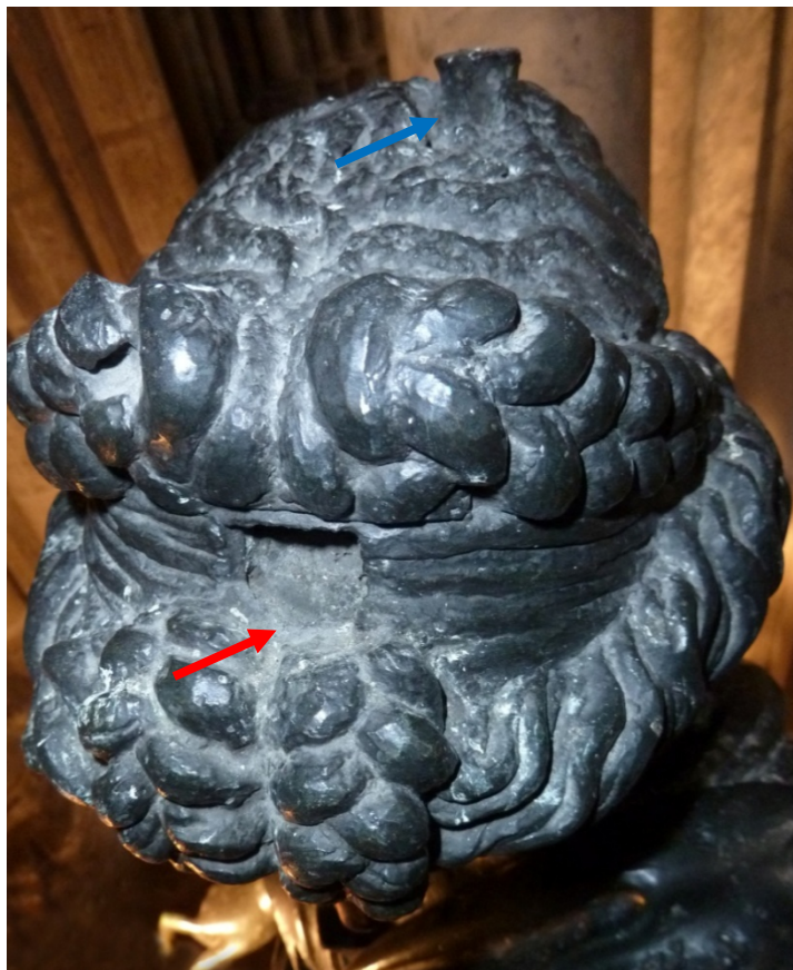
Figure IV 1.2-19 : Tempérance. Détail de l'avant du haut de la tête qui présente un manque (flèches rouges) au niveau du bandeau correspondant à une plaquette de réparation disparue. A l'arrière, on aperçoit l'extrémité de l'armature qui ressort (flèches bleues) © C2RMF M Castelle
