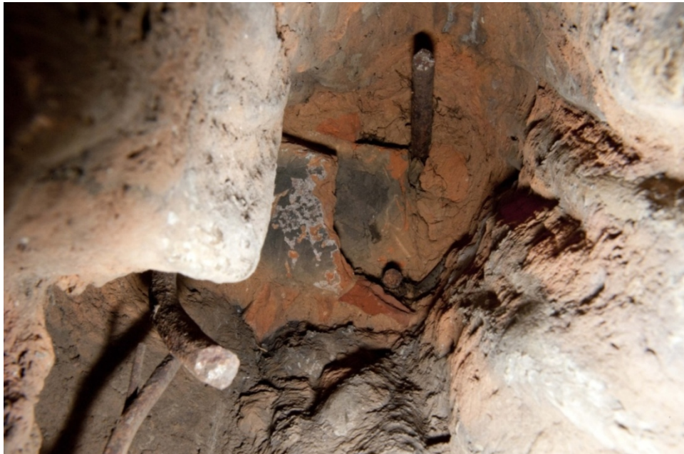
Figure IV 1.3-17 : Paix. Vue de l'ouverture à la base de la statue, détail des armatures (section carrée chanfreinée 10mm) et du noyau composé d'un amas de briques et d'une matrice argileuse © C2RMF A Maigret
