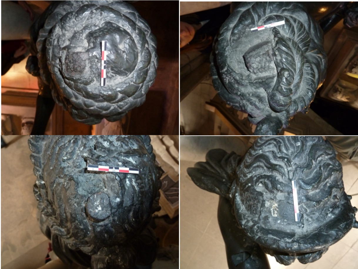
Figure IV 1.2-7 : Détail des armatures qui apparaissent au niveau de la tête des statues. En haut à gauche Force, section carrée (30x30mm). En haut à droite Justice, section carrée (30x30mm). En bas à gauche Prudence, section ronde, (25mm). En bas à droite Tempérance, section carrée (30x30mm) ©C2RMF M.Castelle
