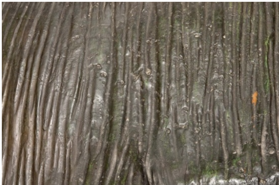
Figure IV 2.1-13 : Diane chasserresse. Détail du vêtement de Diane. L'aspect brut de fonderie de la surface du métal contraste avec le degré de finition pourtant avancé de la statue.
