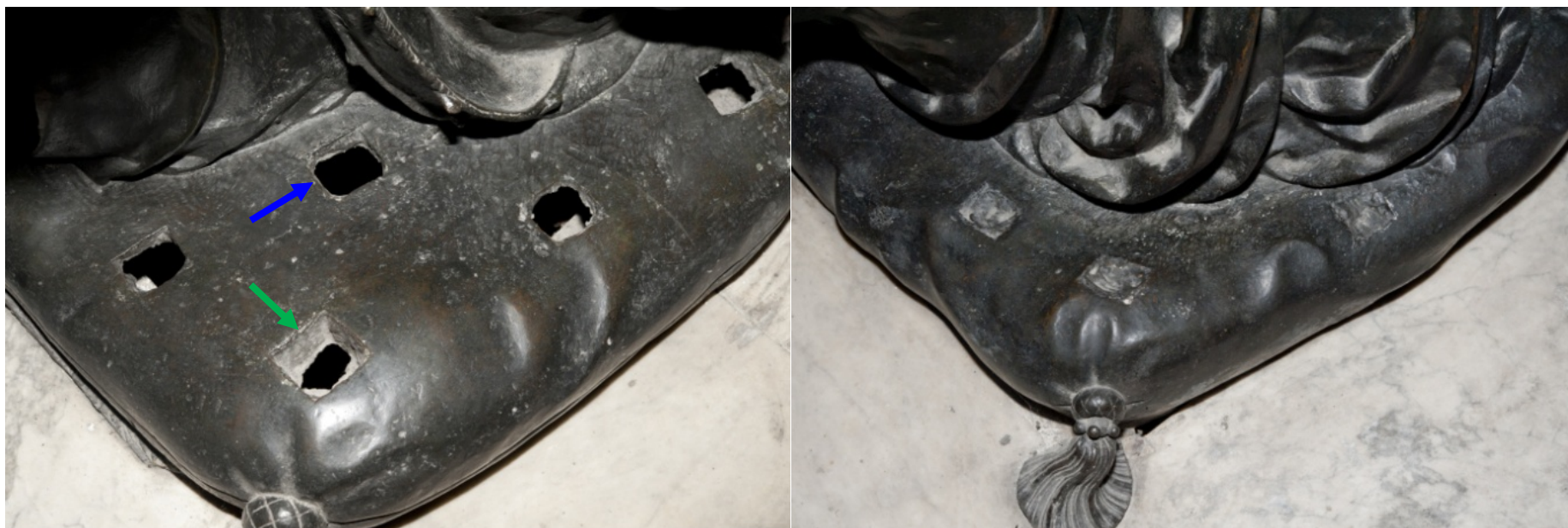
Figure IV 1.2-6 : Statues en priant d'Henri II et de Catherine de Médicis. A gauche : Henri II en priant. Détail du coussin présentant des manques sous forme de carrés (3x3cm). L'épaisseur varie de 8mm (flèche bleue) à 40 mm (flèche verte). A droite : Catherine de Médicis en priant. Détail du coussin présentant des manques, non traversant, sous forme de carrés (3x3cm) © C2RMF A Maigret
