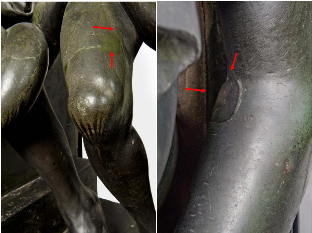
Figure IV 1.1-41 : Laocöon. A gauche : Jambe droite de l'enfant à la gauche du Laocöon, présence de plaquettes de réparation (25x25 et 15x15 mm) (flèches rouges). On observe encore ici des nervures de la surface métallique qui paraissent très superficielles. A droite : Détail de l'arrière de la jambe droite de l'enfant à la gauche du Laocöon, présence d'une plaquette de réparation qui se détache nettement de la paroi (30x30mm) © C2RMF A Maigret
