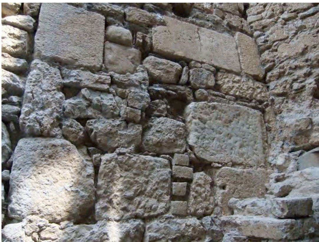
Figura 31 - Museo Archeologico di Grenoble, Saint-Laurent . Dispositivo campanile-atrio. Dettaglio dell'epitaffio inglobato nelle murature esterne della chiesa.
