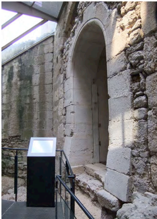
Figura 21 - Museo Archeologico di Grenoble, Saint-Laurent . Dispositivo campanile-atrio. Posizione del dispositivo touchscreen in relazione alla porta. .
