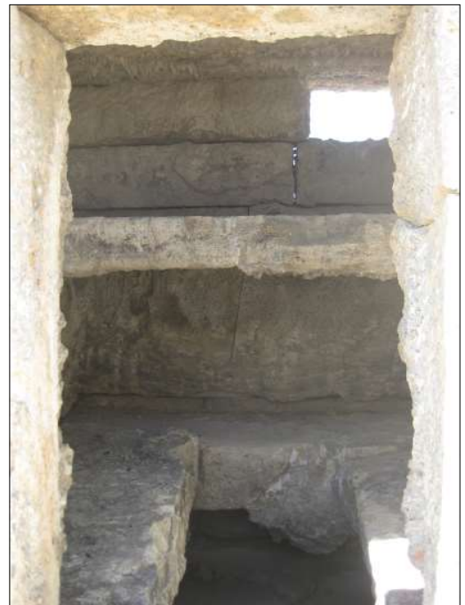
Figure 48 : double niveau de banquettes, nécropole sud Sources : cliché C. Laforest
