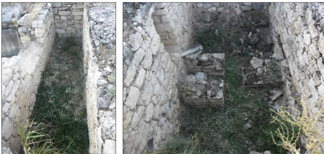
Figure 65 : vue vers le sud-est du «dromos» 163e ; vue vers le sud-est de la pièce voûtée 163f Sources : cliché V. Arnesano
