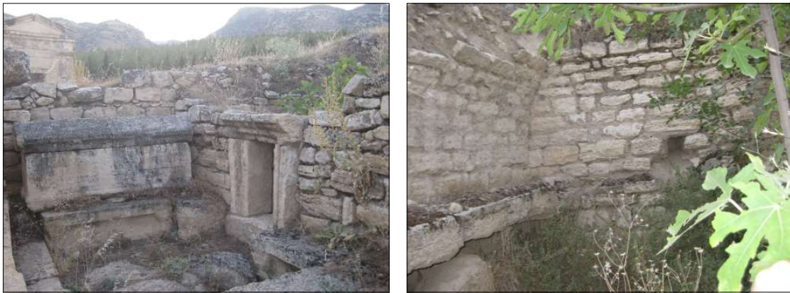
Figure 64 : vue vers le nord de la façade de la structure 163g ; vue vers l'est de l'intérieur de la structure 163g Sources : cliché C. Laforest
