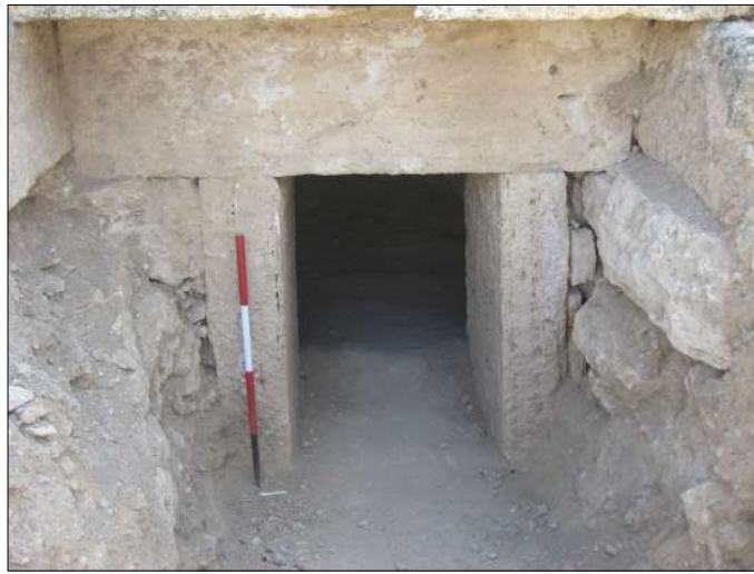
Figure 71 : ouverture de la chambre inférieure de la tombe 163d Sources : cliché C. Laforest
