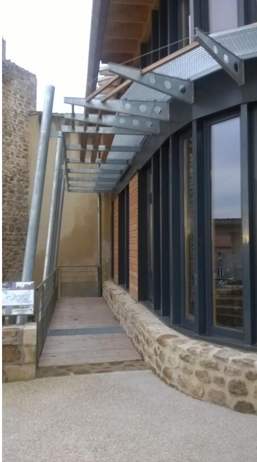
Photo 13 : Façade du bâtiment qui sera végétalisée. E. Kohlmann©
