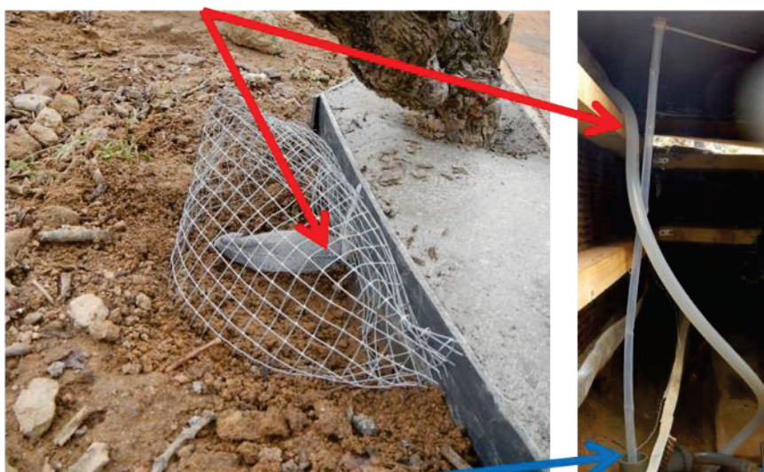
Figure 33 : à gauche, vue extérieure de la bordure cimentée installée pour prévenir l'entrée de ruissellement dans la tranchée. Le tube d'évacuation du point bas est protégé de l'obstruction par une crépine en fibre de verre et un grillage métallique. À droite, vue intérieure de la tranchée, et désignation des différents tuyaux visibles
