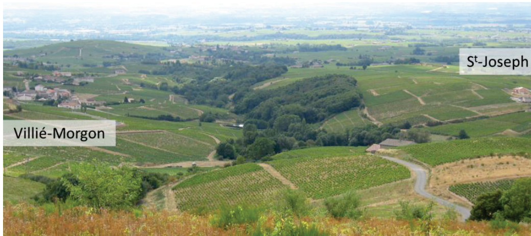
Figure 18 : photographie du bassin versant de la Morcille vue de l'amont. Au centre : talweg de la Morcille
