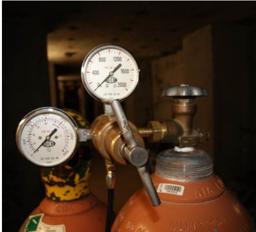
1. Cylindre d'azote comprimé
