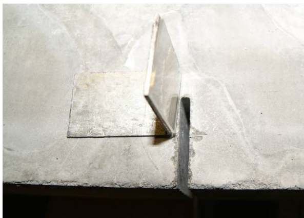
Figure D-5 : Cornière LVDT ouverture de fissure
