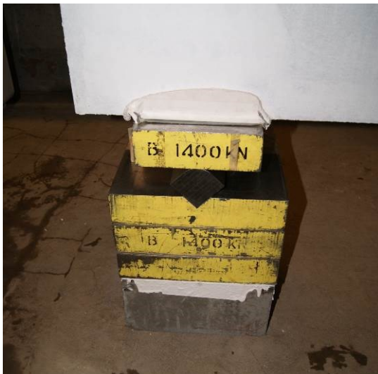
Appui nord de type rotule
