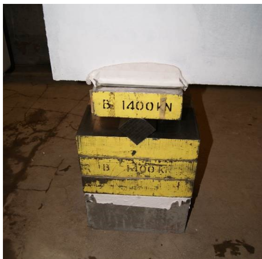
Appui nord de type rotule
