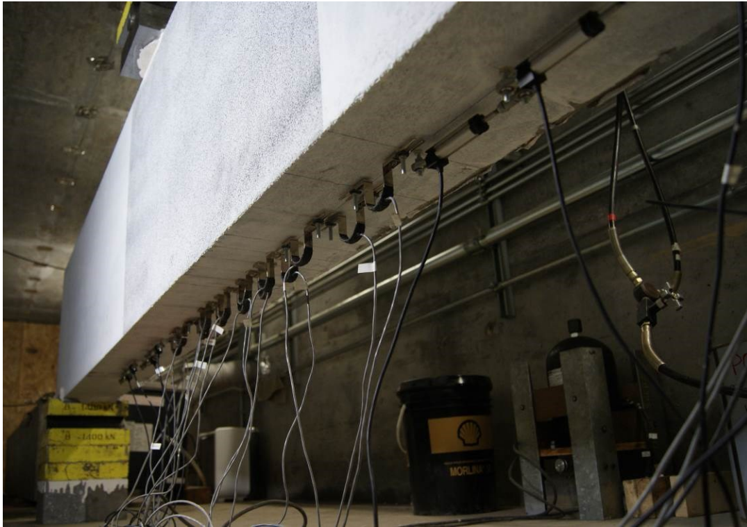
Figure 3.28 : Mesure des ouvertures de fissure sous la poutre – poutre de 4 mètres
