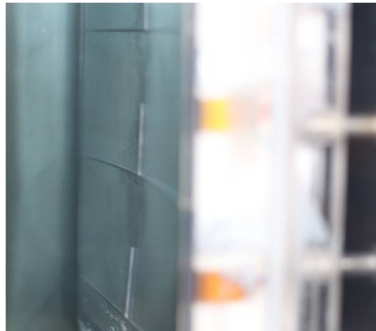
FIGURE 2.6 – La courbure des rainures vues par transparence montre la déformation de la paroi polycarbonate sous la pression de l'eau avant la mise en place des supports.
