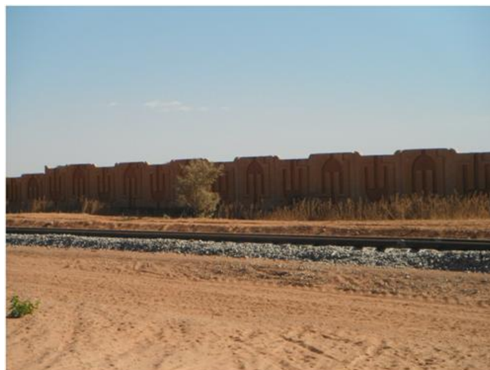
Photo 7 : Voie ferrée longeant l’enceinte du port sec en construction
