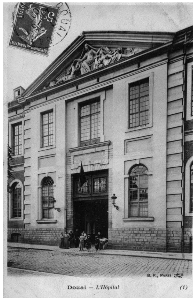
Façade d'entrée de l'hôpital général de la charité de Douai (Archives municipales de Douai, 19 Fi 2390)
