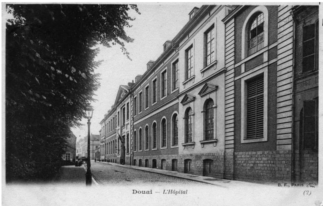
La façade imposante de l'hôpital général de la charité de Douai (Archives municipales de Douai, 19 Fi 2402)
