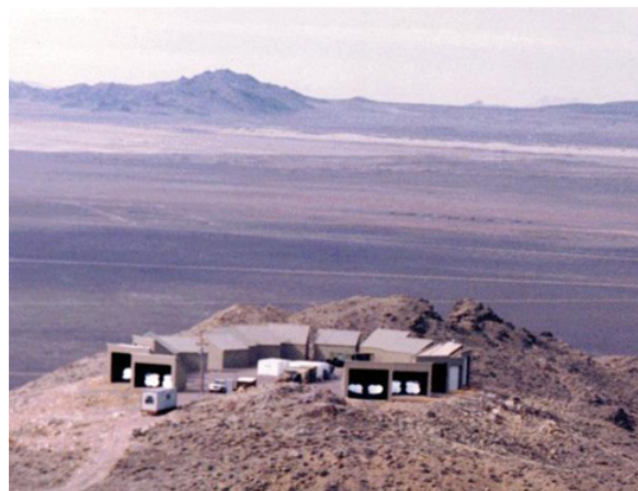
FIGURE 1.3 – Gauche : détecteur de rayons cosmiques Fly's Eye dans l'Utah. Chaque module est constitué d'un miroir réfléchissant la lumière UV sur des photomultiplicateurs. Droite : HiRes II, Utah.
