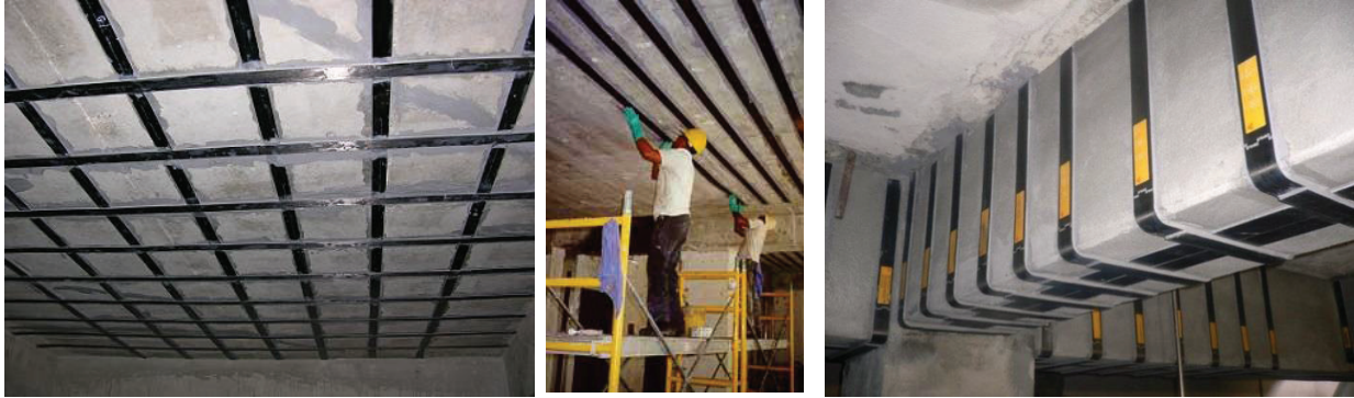
Figure 3: Illustration renforcement par plats consolidés à fibres de carbone (Sika Carbodur®)
