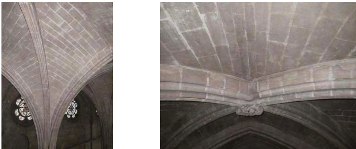
Figure II.4-24: Maçonnerie des voûtes à croisée d'ogives
