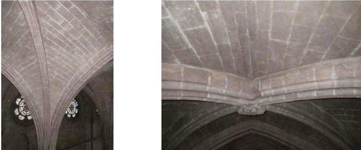
Figure II.4-24: Maçonnerie des voûtes à croisée d'ogives
