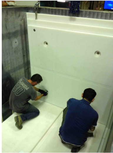
FIGURE 2.43 – Photo du blindage en polyéthylène inséré et fixé sur les plaques de plomb.
