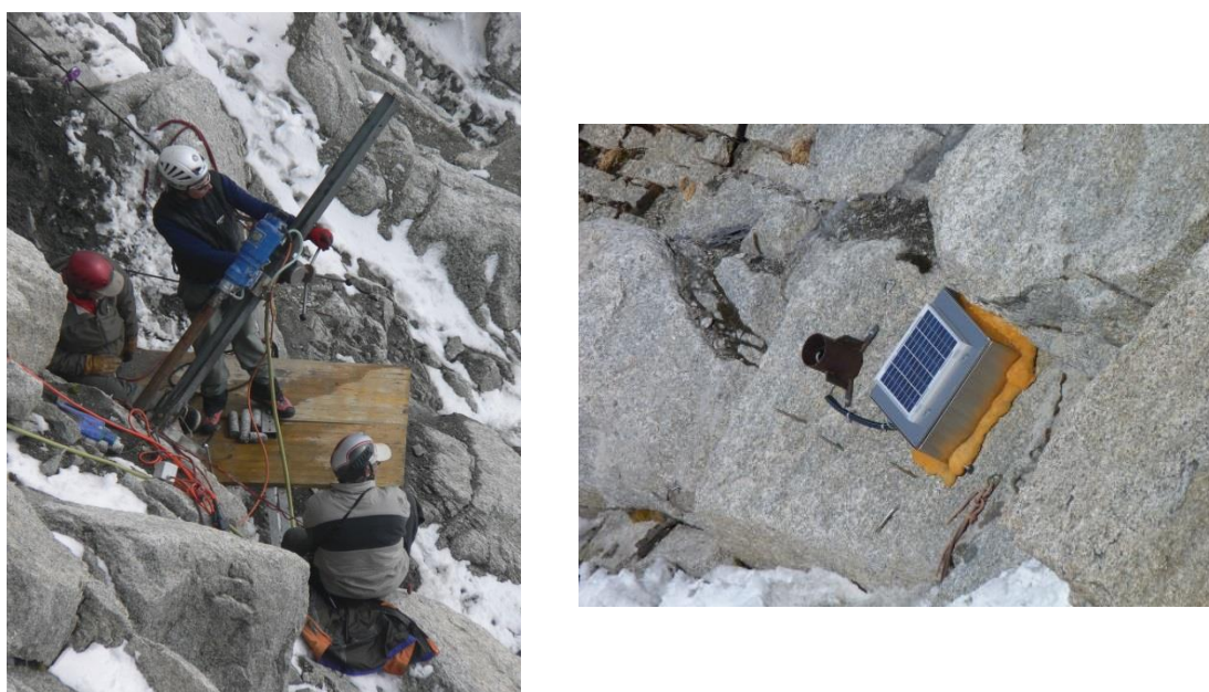
Figure 3.7. Gauche : opération de forage en face sud en septembre 2009 (photo : P. Deline). Droite : boîtier du datalogger avec son panneau solaire et tête de forage en face sud.
