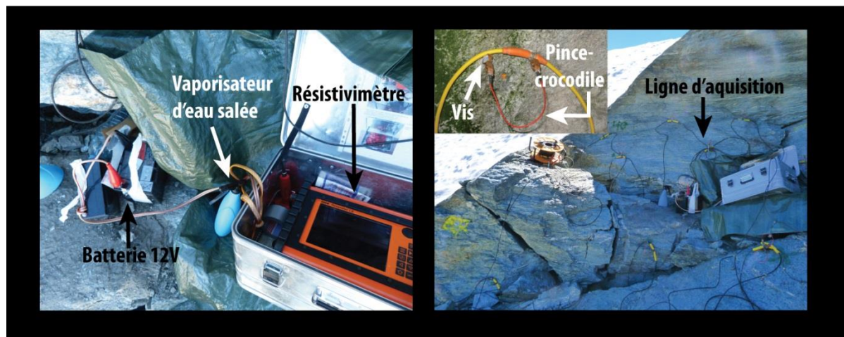
Figure 5.5. Matériel nécessaire à l'acquisition d'un profil électrique 2D : exemple d'application au Steintälli (Vallée de Turtmann, Valais Suisse).
