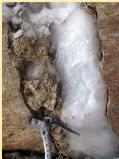
Figure 1.12. Fracture remplie de glace au Stockhorn (3400 m, Suisse).
