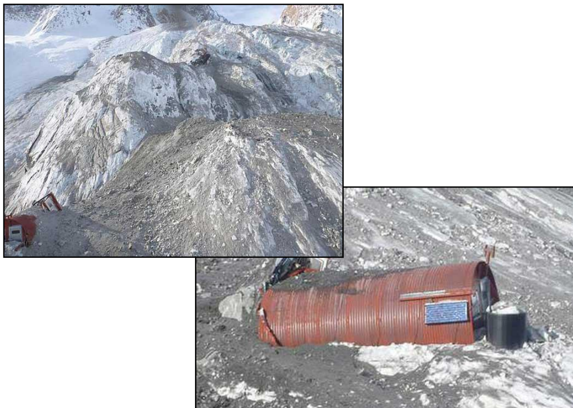
Figure 1.14. Refuge du Mont Cook dans les Alpes de Nouvelle Zélande partiellement enseveli par les débris d'un écoulement en juillet 2014. Source : www.alpineclub.org.nz
