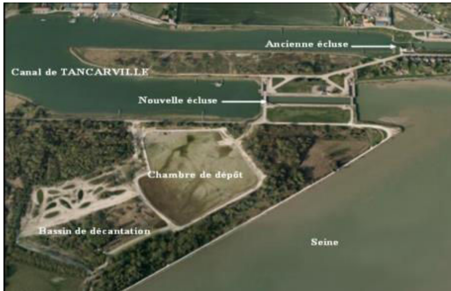
Figure I-6 : Vue d'ensemble de la chambre de dépôt de Tancarville, des écluses et de la zone de décantation.
