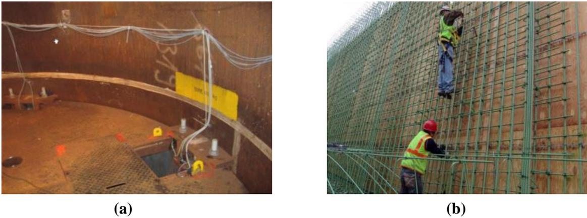
**Figure 1.11 : Insertion d'un réseau de capteur de corrosion au sein d'une éolienne marine (monopile) (a) et au sein d'un pont (b).**
