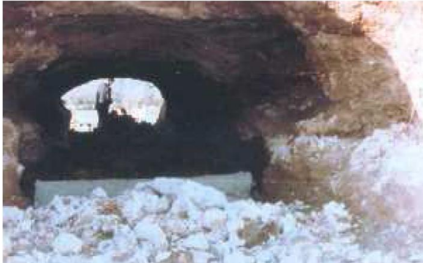
Figure 2. 6: Phénomène de renard dans un barrage (Lautrin, 2002)
