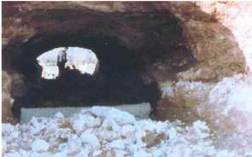
Figure 2. 6: Phénomène de renard dans un barrage (Lautrin, 2002)
