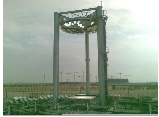
(b) Installation pilote de type Beam Down en construction à Masdar, à Abu Dhabi. Source : site web http://nenmore.blogspot.fr
