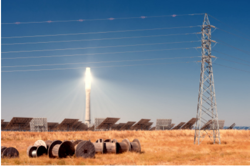
(a) Centrale à tour « classique » Solar Tres, en Espagne. Source : CSP Korea. Photo commerciale.
