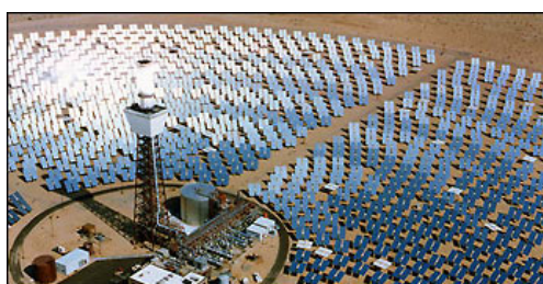
(e) Photo partielle de la centrale à tour Solar Two en fonctionnement, au Nevada. Centrale aujourd'hui démantelée. Source : Wikimedia Commons
