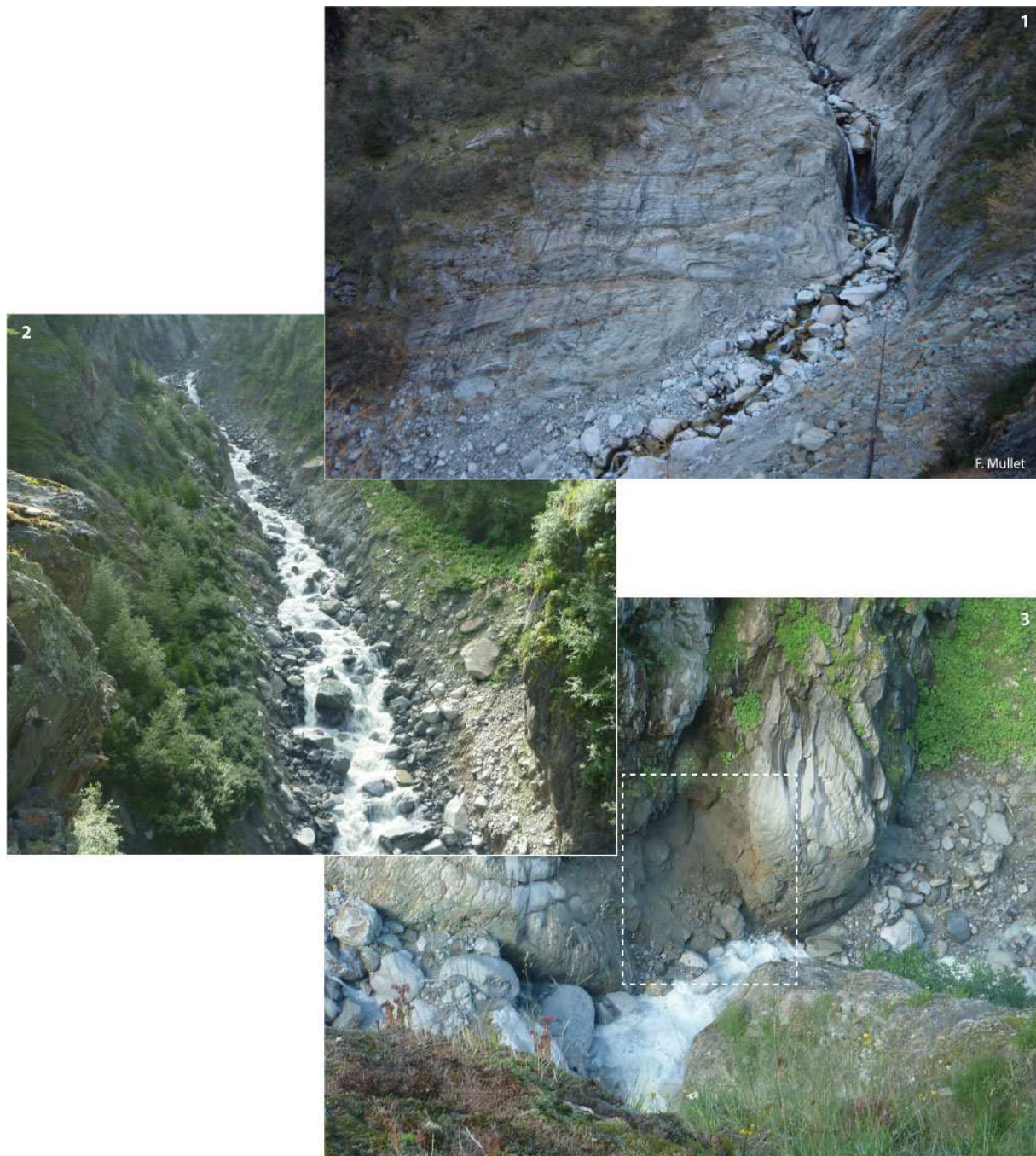
Fig. 6.27 L'incision du torrent de la Creusaz dans ses gorges : (1) la zone de départ de la lave du 7 aout 2014 ; (2) incision dans les gorges ;(3) encoche d'un bloc déchaussé dans un rétrécissement de la gorge.
