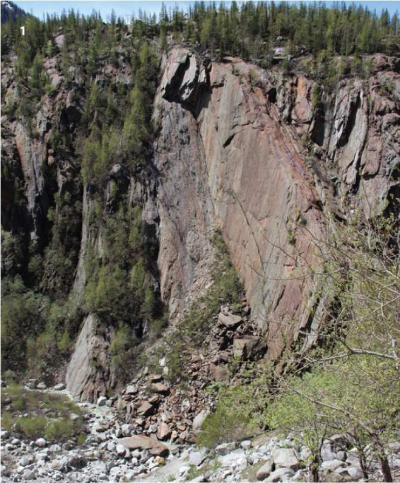
Annexe 3 : Dépôt d'écroulement et ravine dans la marge proglaciaire de la Mer de Glace
