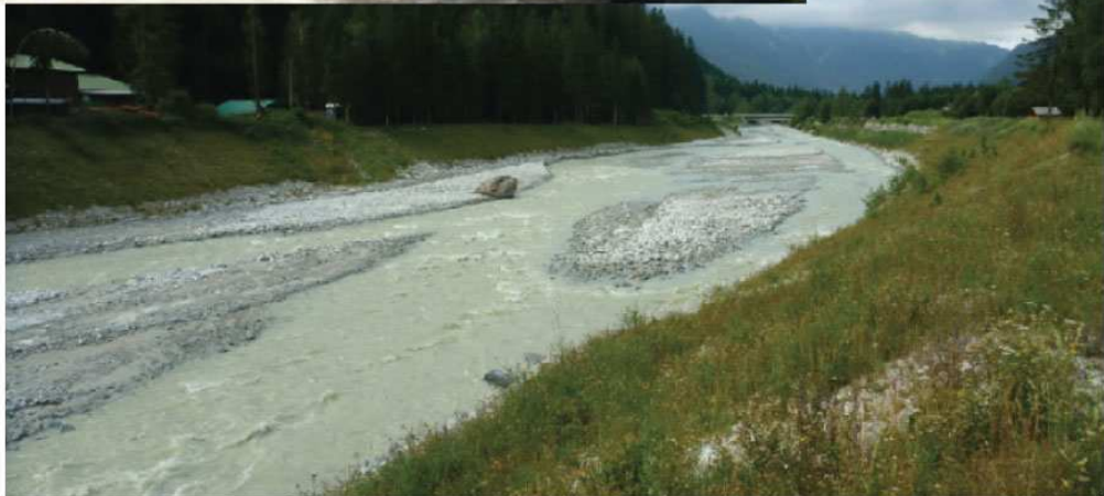
Fig. 2.20 Ouvrages de correction torrentielle et bâti dans le bassin de l'Arveyron de la Mer de Glace ; (1) Le tronçon terminal de l'Arveyron de la Mer de Glace endigué à la fin du 19 ème siècle ; (2) La plage de dépôt achevée en 2005.
