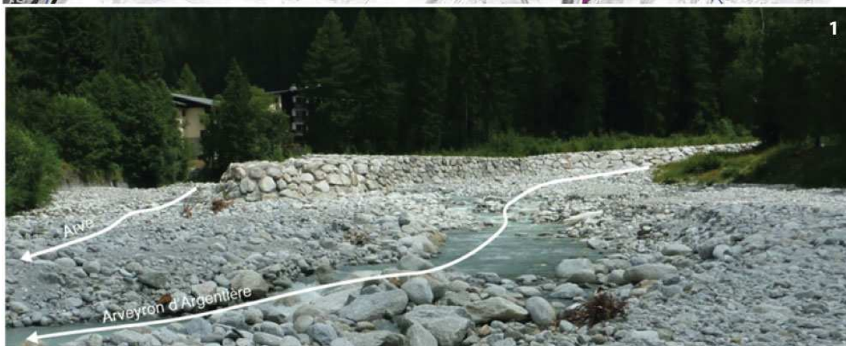
Fig. 2.19 Ouvrages de correction torrentielle et bâti dans les bassins de l'Arveyron d'Argentière et du torrent du Groumot ; (1) L'ouvrage de confluence entre l'Arve et l'Arveyron d'Argentière
