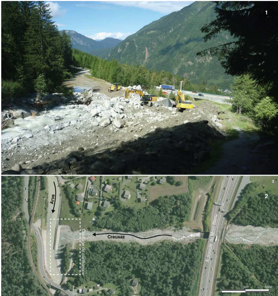
Fig. 2.22 Les plages de dépôts du torrent de la Creusaz : (1) Opérations de curage sur la plage de dépôt à proximité du tunnel du Mont-Banc après la crue du 7 août 2014 (2) Les aménagements sur le tronçon final en amont de la confluence avec l'Arve
