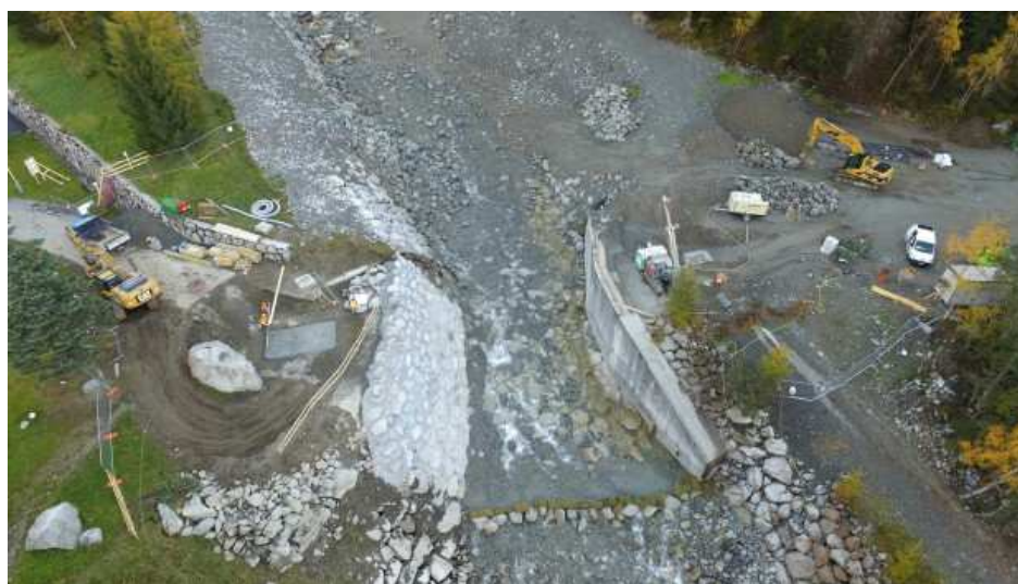
Annexe 9 : Les travaux d'élargissement de la plage de dépôt du tunnel sur le torrent de la Creusaz, source : ATMB
