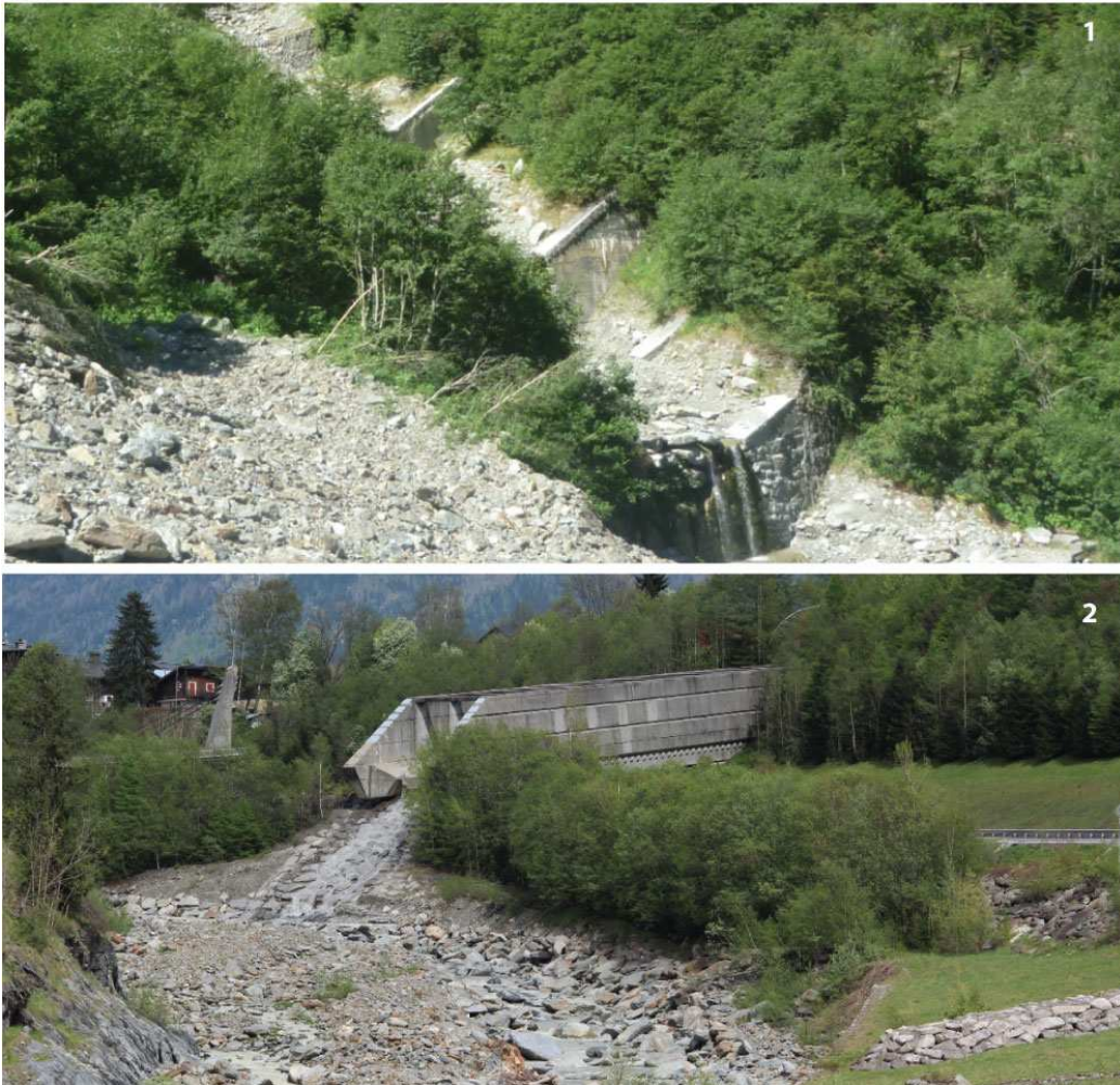
Fig. 2.26 (1) Seuils RTM sur l'affluent des Arandellys du torrent de la Griaz. (2) Confluence du torrent de la Griaz avec l'Arve
