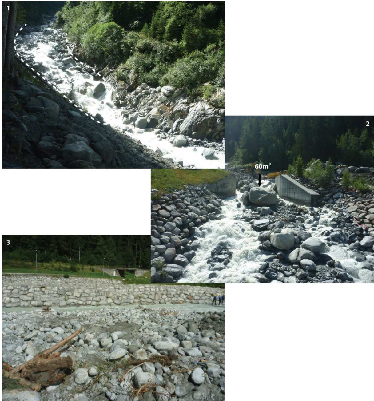
Fig. 6.28 Les dépôts sur le torrent de la Creusaz après la crue du 07/08/2014 : (1) bourrelet de matériaux à l'aval des gorges ; (2) blocs obstruant le verrou de la plage de dépôt du tunnel ; (3) plage de dépôt de la confluence avec l'Arve.
