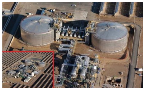
Figure 11 : Système de stockage d'énergie à deux réservoirs de la centrale solaire Andasol, en Espagne. Chaque réservoir fait 36 m de haut et 14 m de diamètre. ©Andy Skumanich [39].
