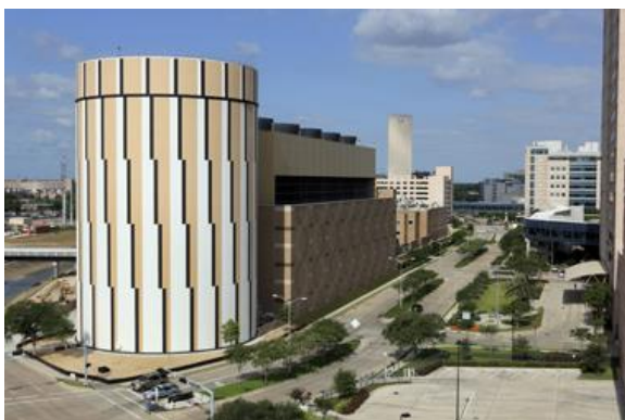
Figure 10 : TTES aux USA, à Houston : 45 m de haut, 30 m de diamètre. ©Paul Howell et Burns & McDonnell (burnsmcd.com).
