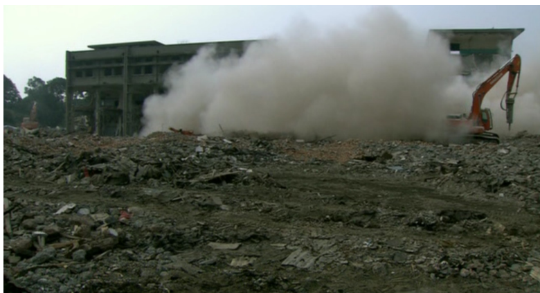
FIG. 11 : Destruction de la cité ouvrière de L'usine 420 à Chengdu, dans 24 City (2008). Voir SCENE 4: https://www.dropbox.com/s/m1ktmf3794sec5o/SCENE4-24_City.mp4?dl=0
