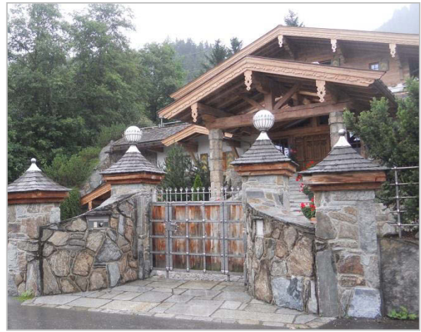
Photographie 2.3 : Le bois et la pierre, outils privilégiés des pastiches de l'architecture vernaculaire des stations de sports d'hiver. Habitation localisée à Kitzbühel, L. Piquerey, août 2014.
