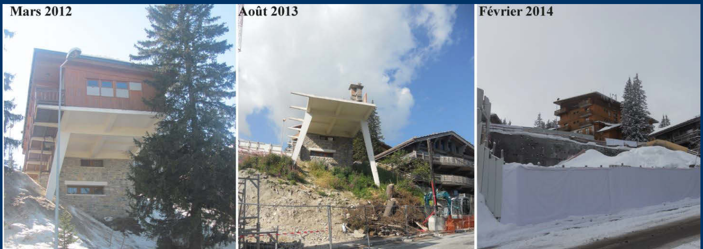
Composition photographique 3 : Le chalet Lang à Courchevel 1850 : vie et mort de l'aventure de l'architecture de montagne
