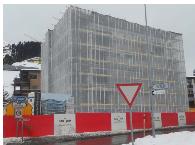
Photographie C.II : Construction d'un immeuble collectif par un promoteur privé à Davos Dorf. Prix d'appel pour un T 3 : 891 000 euros. L. Piquerey, janvier 2013.
