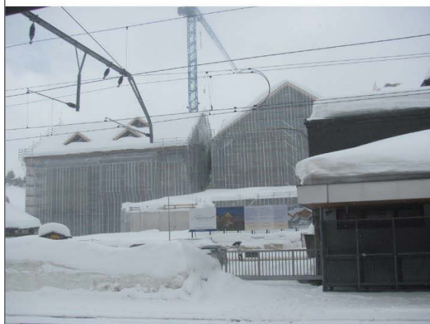
Vue sur le chantier de construction de l'hôtel cinq étoiles superior « The Chedi », Andermatt, Uri. L. Piquerey, mars 2011.
