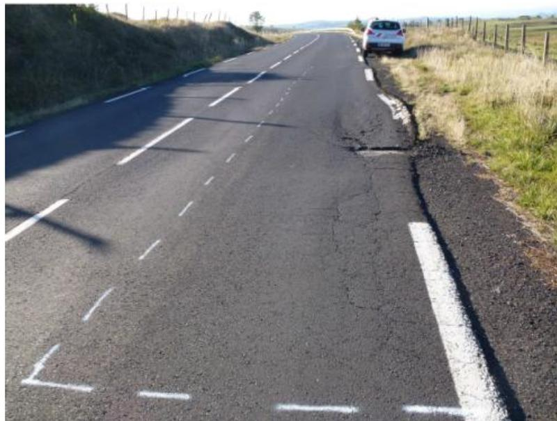
Figure 1 : Dégradations et défauts de collage d'interface (RD3, Cantal, France)
