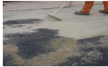
(b) Mise en œuvre de la couche de séparation
