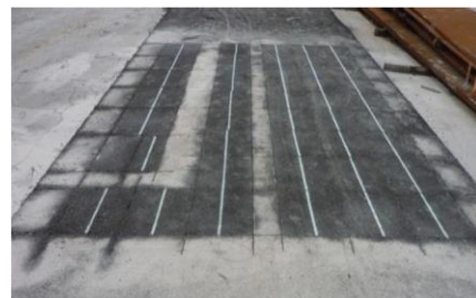
(e) Découpage et numérotation des plaques
