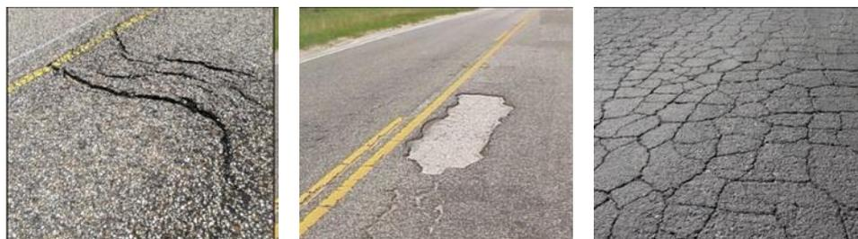
Figure I. 20 : Dégradations relatives à des défauts de collage (Asphalt Technology News, 2015)
