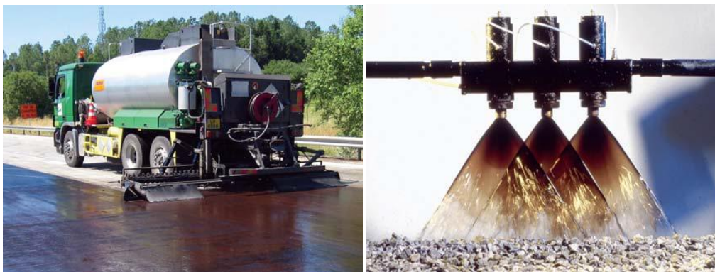
Figure I. 31 : Mise en œuvre d'une couche d'accrochage (Destrée A. and Brichant P.-P, 2012)
