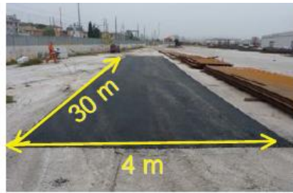
(a) Compactage de la couche de régulation
