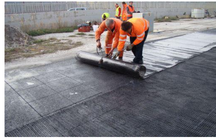
(c) Préparations des couches d'accrochage et installation des géo-grilles en fibre de verre et en fibre de Carbone
