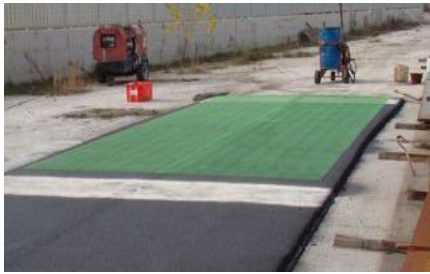
(c) Préparations des couches d'accrochage et installation des géo-grilles en fibre de verre et en fibre de Carbone
