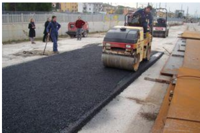
(d) Mise en œuvre de la couche supérieure
