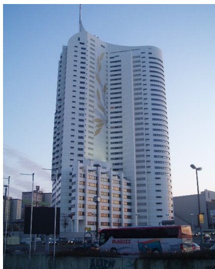
Figure 22 : Gratte-ciel Donau City (promoteur : Arwag), Vienne Donaustadt / Hochhaus in der Donau City (Arwag Bauträger), Wien Donaustadt
