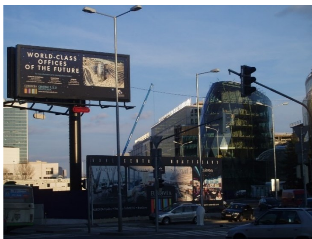
Figure 26 : Construction de l'ensemble multifonctionnel Eurovea / Bau des multifunktionalen Zentrum Eurovea
