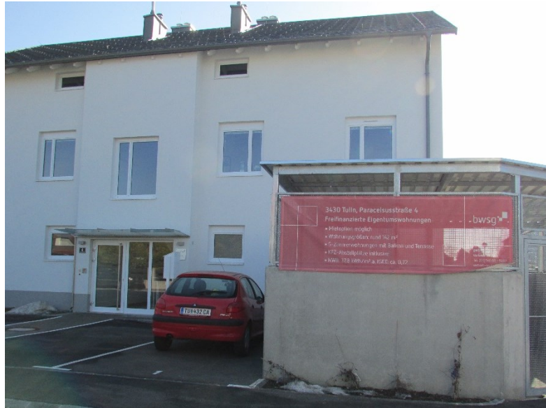
Figure 93 : Construction d'appartements en accession à la propriété par le promoteur BWSG, Tulln, Basse-Autriche / Neubau von Eigentumswohnungen von der BWSG in Tulln, Niederösterreich
