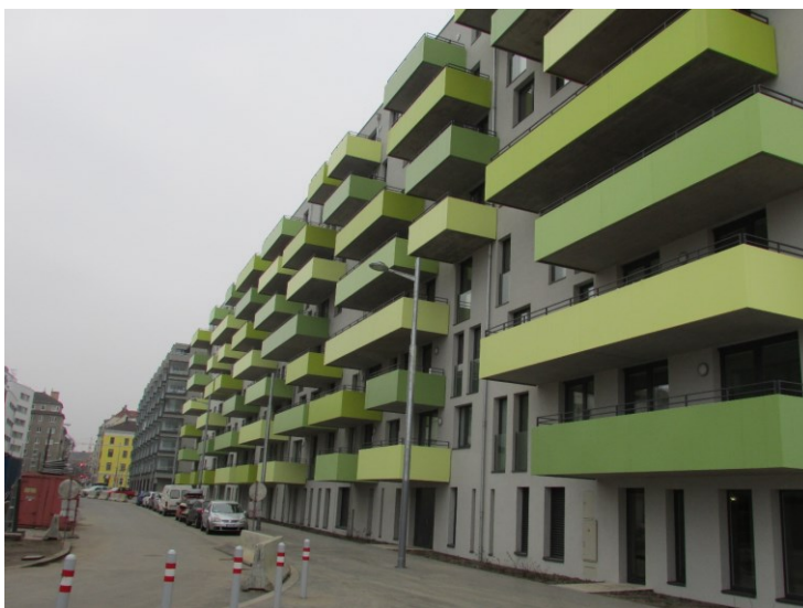
Figure 92 : Construction du promoteur BWSG dans le cadre du grand projet urbain Sonnwendviertel / Wohnungsprojekt der BWSG im Rahmen des Sonnwendviertels, 10. Bezirk, Wien
