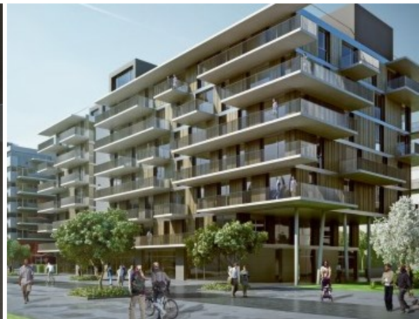
Figure 69 : Habitat groupé Wohnprojekt Wien, Vienne 2 / Baugruppe Wohnprojekt Wien, 2. Bezirk, Wien
