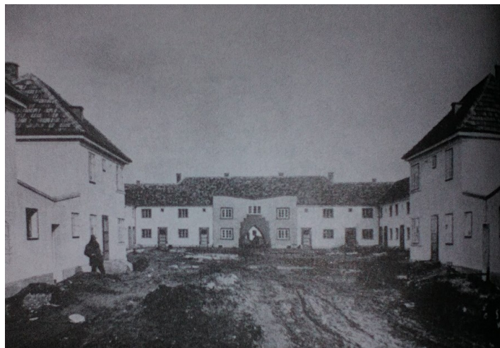
Figure 3 : Siedlung à Kagran, Vienne, 1923 / Siedlung Kagran, Wien, 1923
