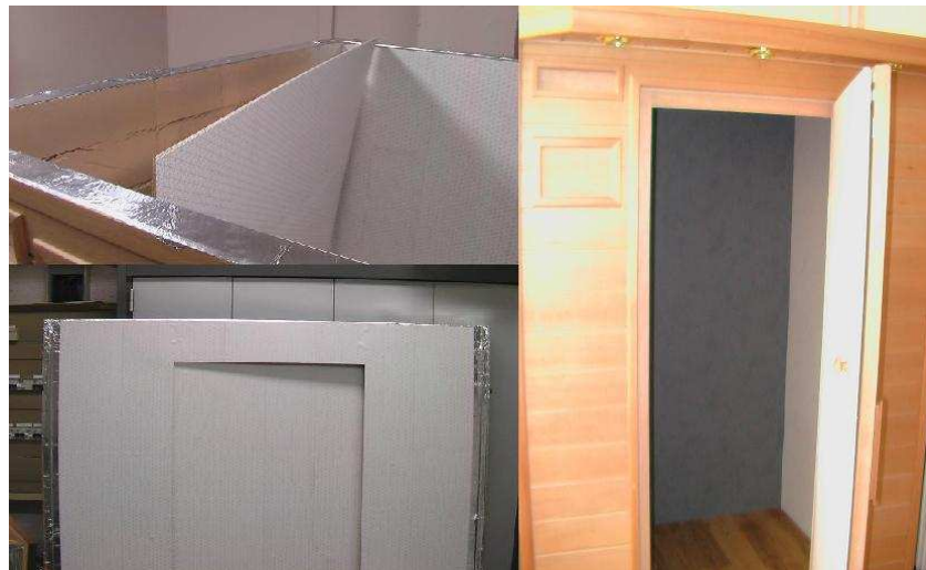
Figure 134 : Photographies de la mise en place du métapapier dans le sauna et du résultat final.
