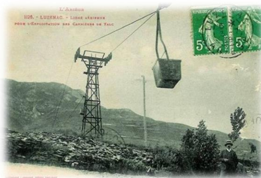
Figure I-6 : Le premier téléphérique à Luzenac.
