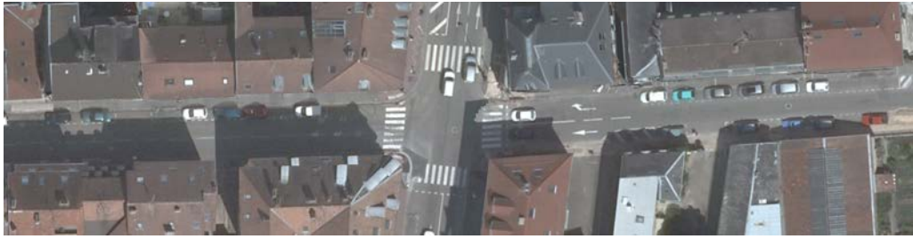
FIGURE 5.15 – Vue aérienne d'un carrefour du quartier Denfert-Thiers avant travaux.
