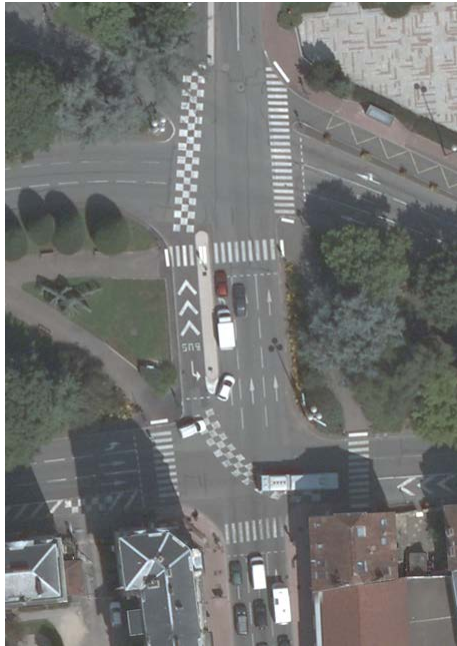
FIGURE 5.11 – Vue aérienne d’un carrefour de la place Rabin avant travaux.
