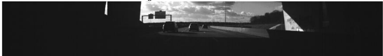
Figure IV.61 Entrée de tunnel
