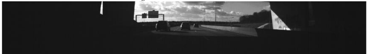
Figure IV.61 Entrée de tunnel
