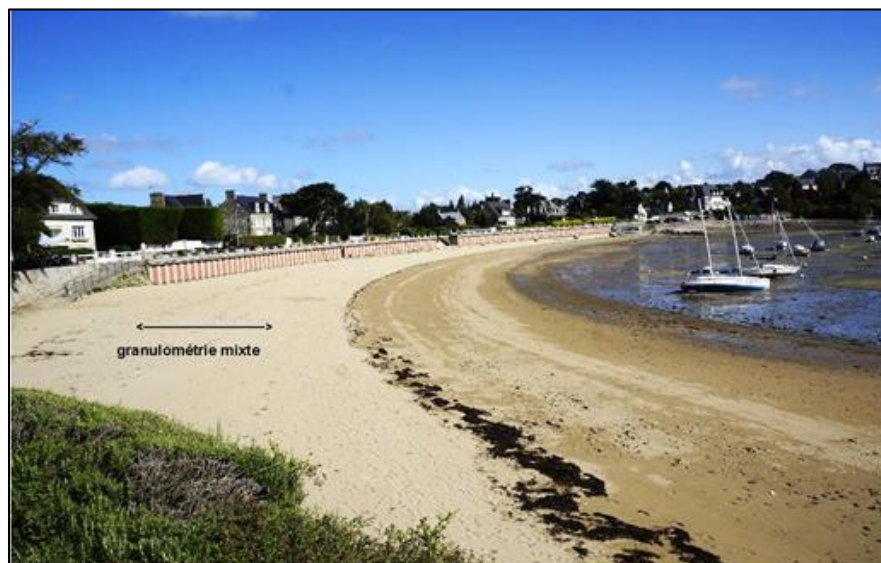
Figure 39 : mur de défense. Saint Briac plage de longchamp, plage totalement artificielle Avril 2012
