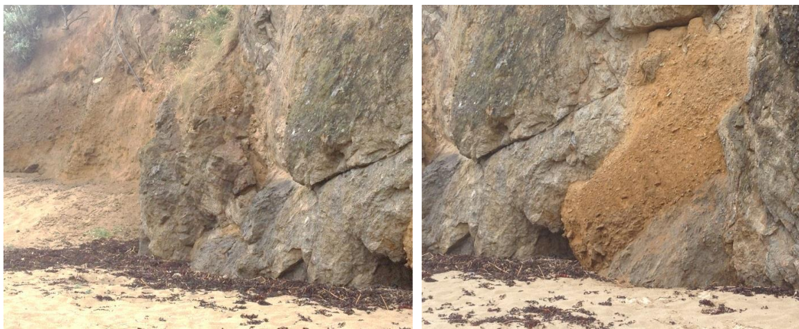
Figure 200 : reste de matériel de falaise meuble quasi totalement érodé
