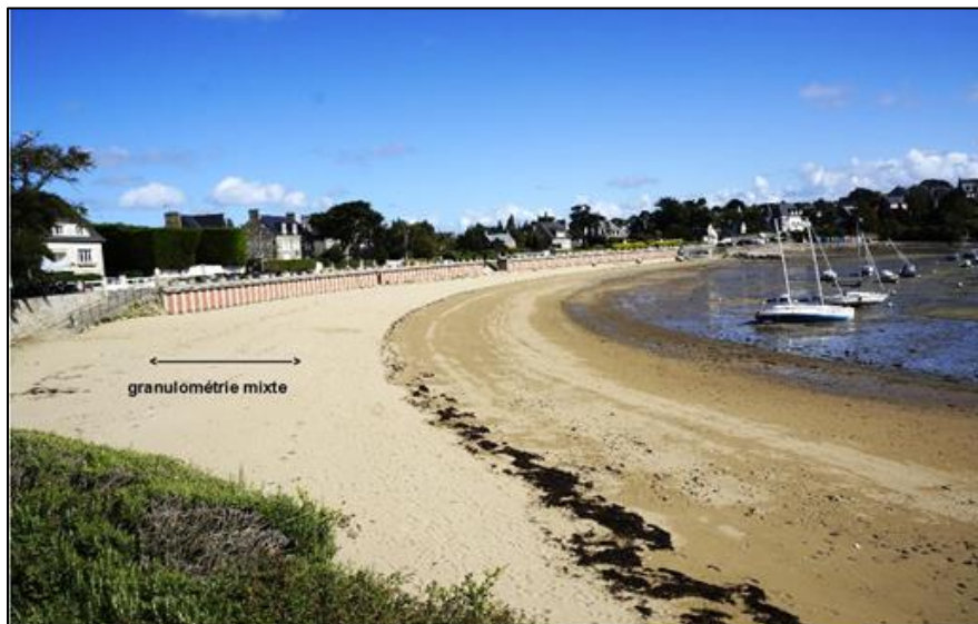
Figure 39 : mur de défense. Saint Briac plage de longchamp, plage totalement artificielle Avril 2012
