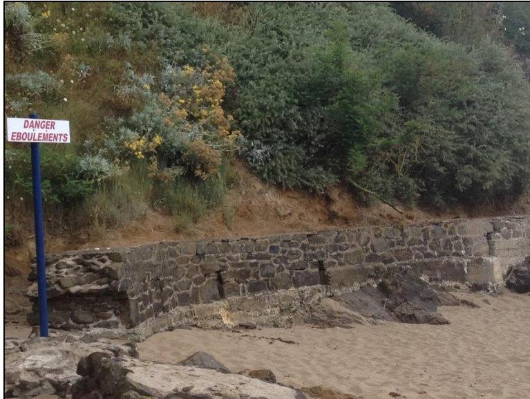
Figure 201 : plage de la Mare mur de protection
