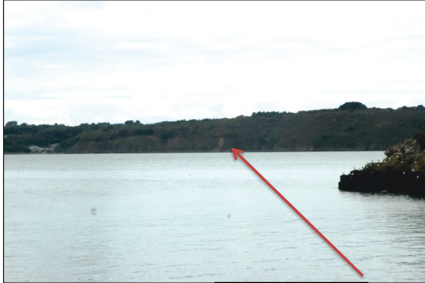
Figure 51 : Un effondrement actuel (Septembre 2015) sur la rive nord de la Baie de la Fresnaye. D'autres, plus anciens, sont re-colonisés par la végétation.
