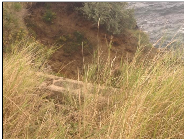
Figure 43 : falaise meuble « aménagée » par un pylône.
