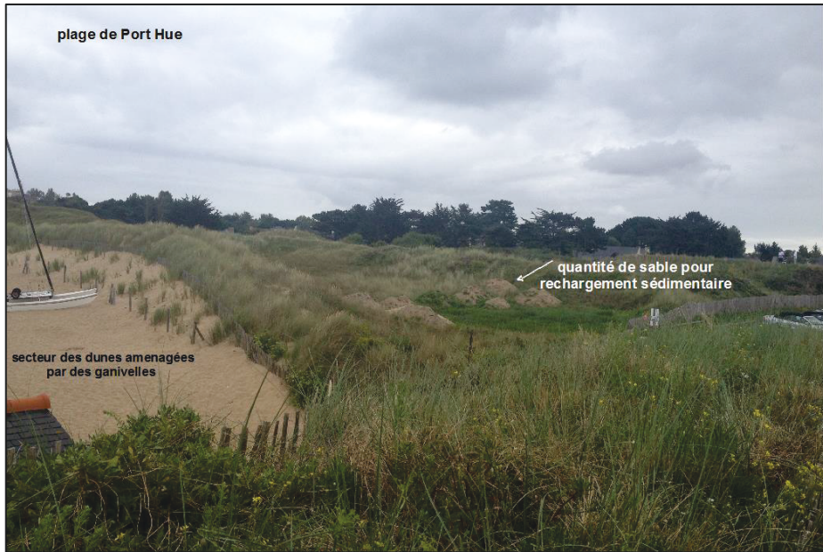
Figure 182 : plage de Port Hue, aménagement « doux » de reprofilage et de rechargement sédimentaire
