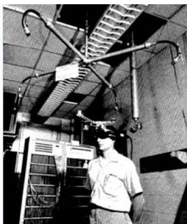
FIGURE 7.2.2 – Projection d’image de synthèse dans le champ visuel humain : le tout premier dispositif de RA par [Sutherland, 1968]
