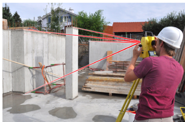
FIGURE A.5 – Visée laser au tachéomètre sur une surface
