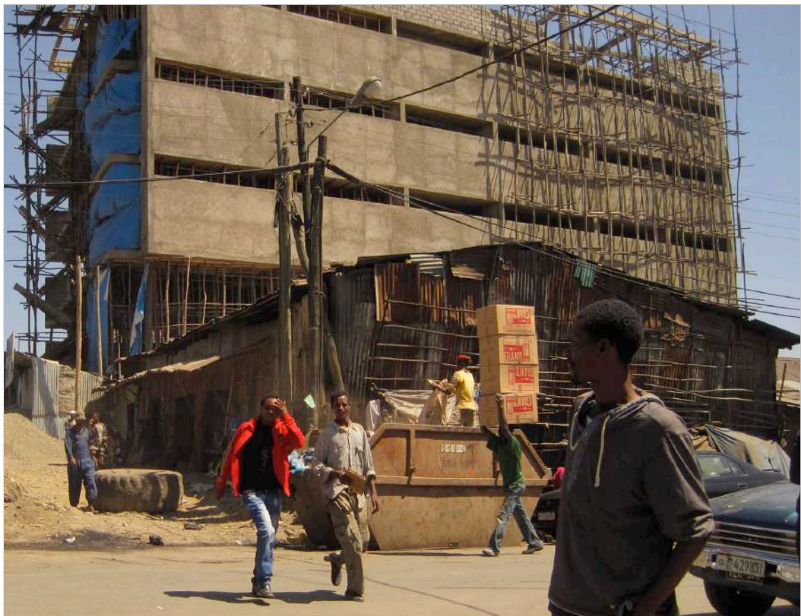
Échaffaudages en eucalyptus sur un immeuble en construction à Addis Abäba (©A.Pierrat, 2012)
