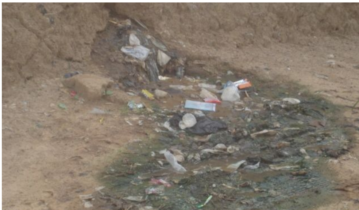
Photo 6 : écoulement d'eaux usées provenant d'une douche familiale
