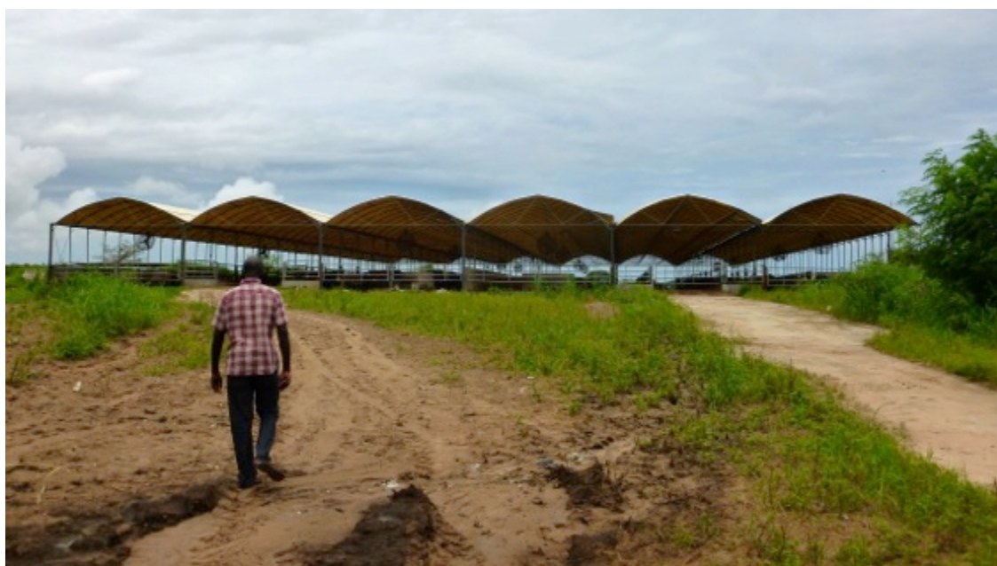
Photo n°5-1. Bâtiment à logettes de la Ferme de Wayembam. Bambilor, sept. 2013.
