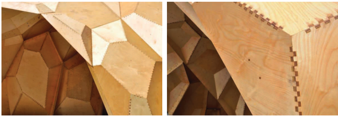
Figure 2. L'assemblage des panneaux en bois.
