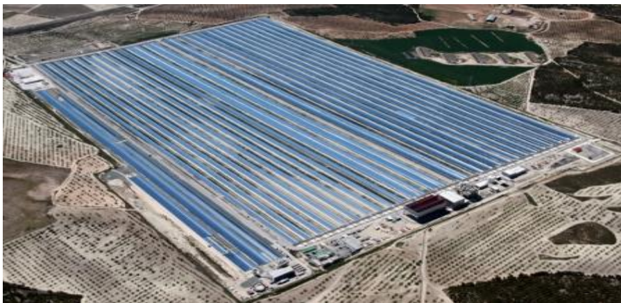
Figure 26. Centrale Puerto Errado 2 en Espagne
