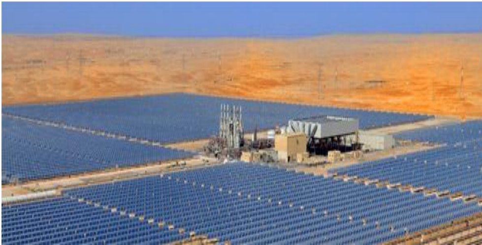
Figure 25. Centrale solaire « Shams 1 » à Abu Dhabi
