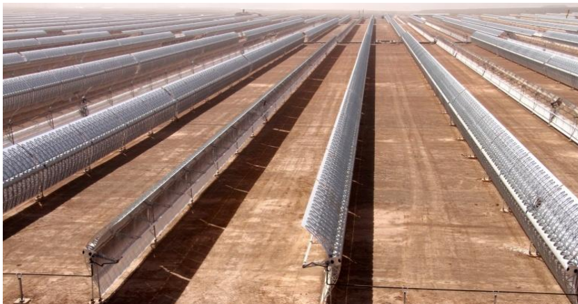
Figure 32. Le complexe solaire Noor-Ouarzazate au Maroc
