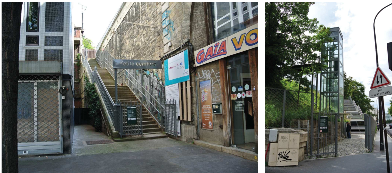
Photos 88 : Entrées de la PC, discrète à gauche rue de Vaugirard, imposante à droite, place Balard. Photos personnelles, août 2014.
