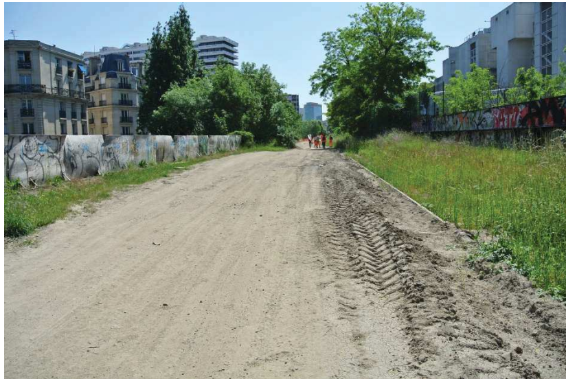
Photo 92 : La plateforme pendant les travaux. Photo personnelle, juin 2013.
