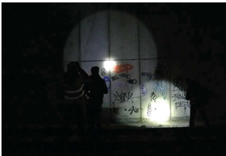
Photo 12 : Les murs du tunnel sur la PC14, lors d'un comptage de chauve-souris. Photo personnelle, 2013.
