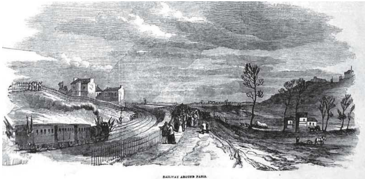
Figure 12 : Train de l'inauguration de la première section de la petite ceinture en 1852, construite dans un environnement encore rural. Gravure extraite du n° du 29 janvier 1853 de l'hebdomadaire The Illustrated London News. Source : http://www.petiteceinture.org/Histoire-de-la-Petite-Ceinture-7.html , consulté le 04/07/2015.
