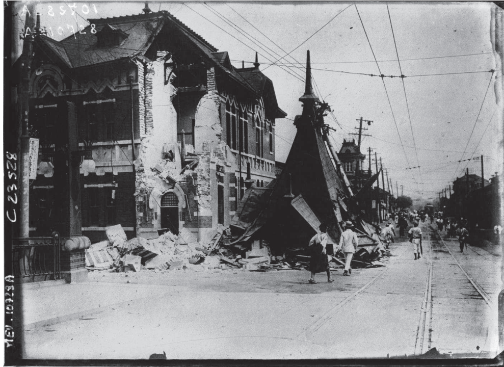
FIGURE 1.2 – Destruction des bâtiments construits en brique dans le centre de Tokyo Source : Agence Meurisse, Tokyo : tremblement de terre de 1923, 1923 [En ligne] http://gallica.bnf.fr/ark:/12148/btv1b90243768 Consulté le 20 octobre 2014)
