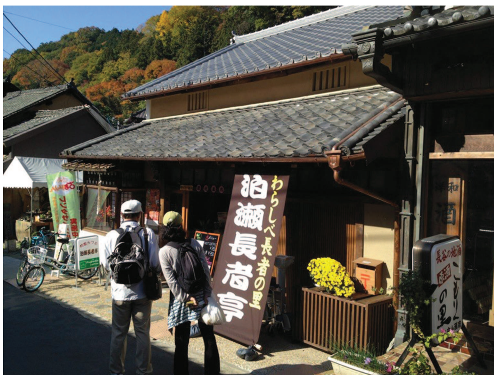
FIGURE 2.22 – La machiya après rénovation. Source : ABE Toshihiko
